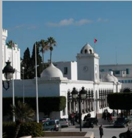
Ministère des travaux publics, Tunis
